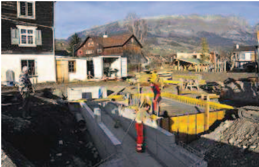
Am neuen Standort: Unterhalb des Gehlerhauses laufen die Arbeiten für den neuen Wasserkanal und das Gebäudefundament.
