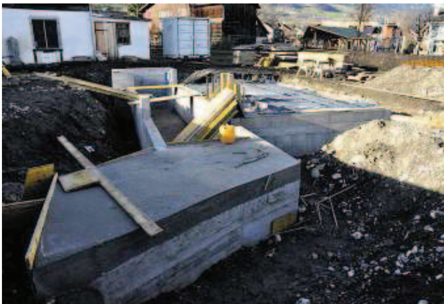
Die Vorarbeiten sind abgeschlossen, die Messerschmiede kann kommen.
