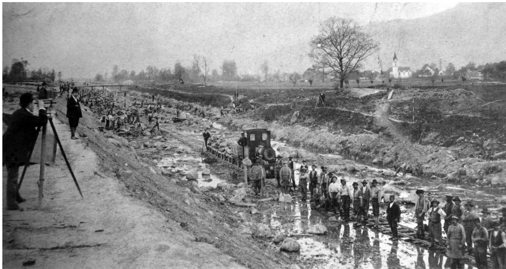
Das Werk italienischer Erdarbeiter: Der Werdenberger Binnenkanal (hier während der Bauarbeiten bei Salez, 1882/83) wurde grösstenteils von Wanderarbeitern aus Italien und dem Südtirol ausgehoben. Allein in der Gemeinde Sennwald waren von November 1882 bis Juni 1883 fast 550 Italiener und Tiroler gemeldet. Schon beim Bau der Eisenbahnlinie 1857/58 standen im Rheintal italienische Gastarbeiter im Einsatz. Bild im Staatsarchiv St.Gallen
